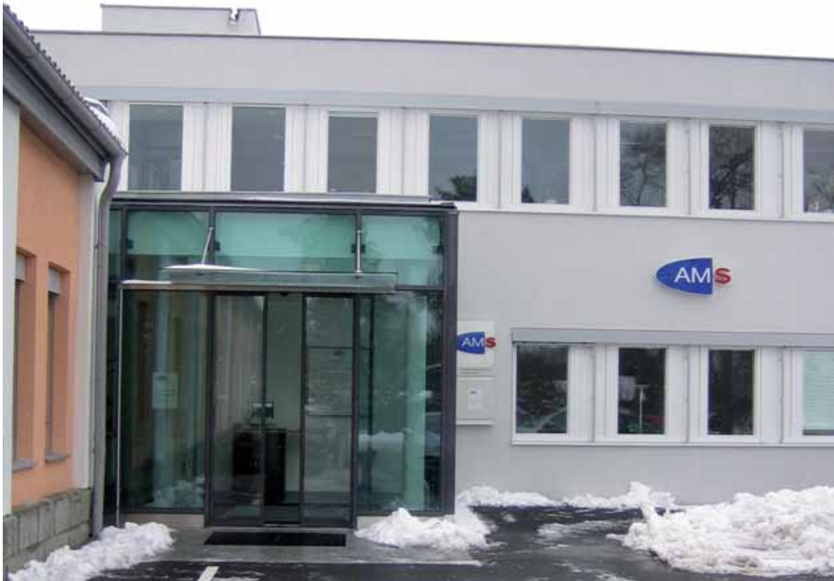
Die neue Geschäftsstelle des AMS Schwechat wurde 2004 in Betrieb genommen und im März 2005 eröffnet.
