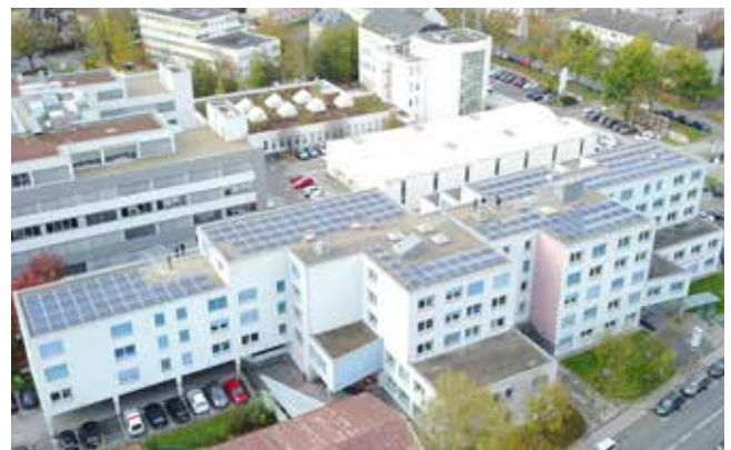
Die Leistung der Photovoltaikanlage in Klagenfurt wird auf einem Monitor im Foyer der Landesgeschäftsstelle dargestellt.
