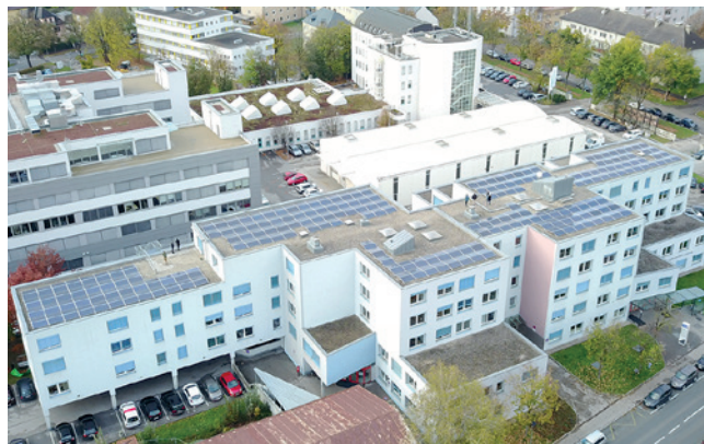
Die Leistung der Photovoltaikanlage in Klagenfurt wird auf einem Monitor im Foyer der Landesgeschäftsstelle dargestellt.
